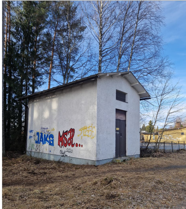
Kuva 6 Kuva suunnittelualueen pohjoisosan puistomuuntamosta. (kuva: Tia Koponen 2.4.2025)
